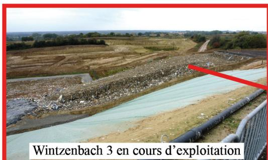
Le SMICTOM exploite, sur le site de Wintzenbach, un Centre de Stockage de Déchets Non Dangereux. Il occupe actuellement une superficie de 7,5 ha et son exploitation est d'environ 35 000 tonnes par an.
